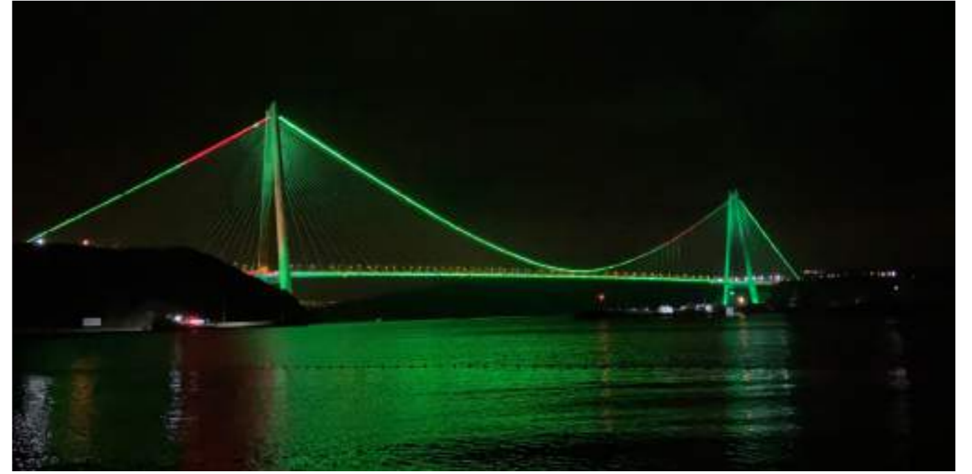
Yeşilay Haftası kapsamında Yavuz Sultan Selim Köprüsü yeşil ışıkla aydınlatılmıştır.
